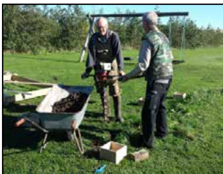
Der støbes sokkel til tårnet
