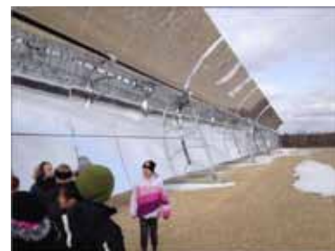
Thisted kraftvarmeværks solfange-anlæg
