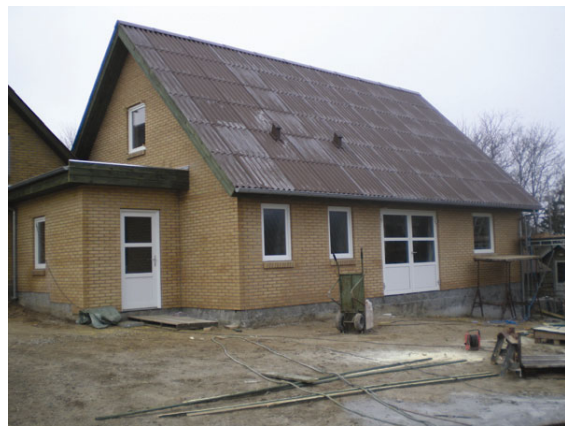
Her er huset den 15. december 2007, og rigtig meget er selvfølgelig sket siden da.
